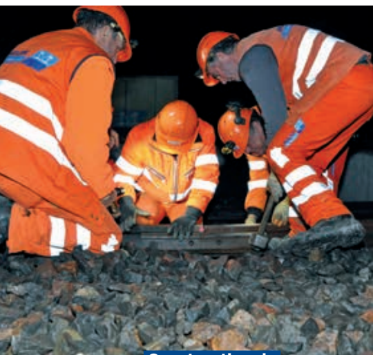
Construction de voies ferrées
