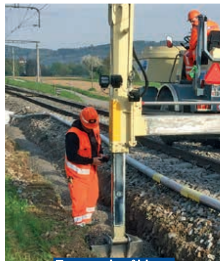
Travaux de câblage
