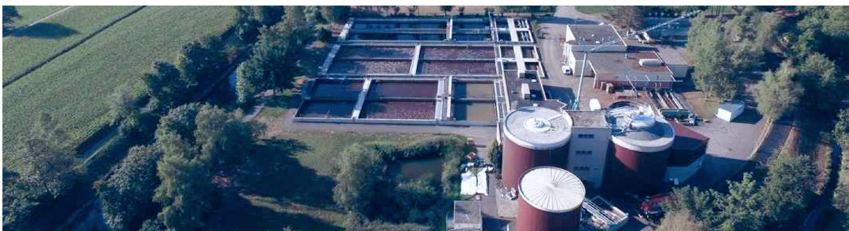
Durch das Stripping-Verfahren werden die Lachgasemissionen deutlich reduziert, zudem wird ein reiner, hochkonzentrierter Ammoniumsulfatdünger von bekannter, stabiler Qualität produziert. Dieser kann mit geeigneten Methoden genau dosiert in der Landwirtschaft eingesetzt werden.
