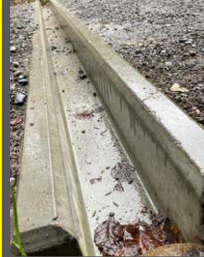
Unsere Wasserrinne vom Typ Till eignet sich ideal für den Einbau bei Flurwegen. Sie besitzt keinen Rost, sodass **keine Verstopfungen** durch Laub oder Pflanzenreste entstehen können.
