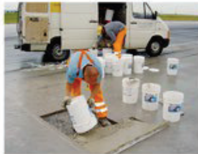
Einbau Es wird empfohlen bei größeren Maßnahmen mit 2 Personen zu arbeiten, damit stets „frisch in frisch“ eingebaut werden kann.
