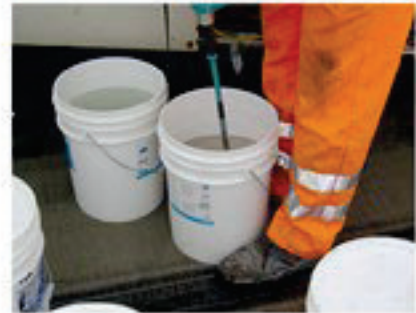
Mischen TOK®-Crete 45 V2.0 mit Wasser anmischen (20 kg = 1,2 Liter Wasser).
