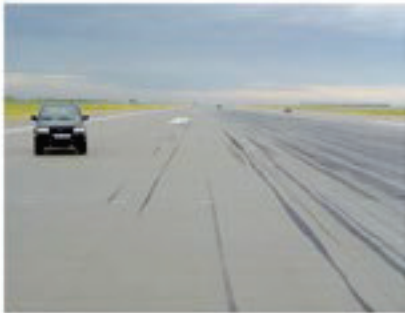
Flugfeld Betonoberfläche Start- und Landebahn am Flughafen Leipzig.
