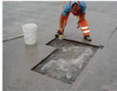
Vorbereitung Vorbereitete Fläche vornässen. Haftgrundierung ist nicht erforderlich.
