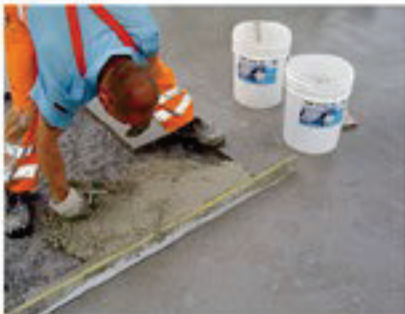
Einbau Anschließend zügig einbauen, da die Topfzeit 10 Minuten beträgt.
