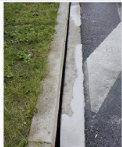
Fertige Reparatur Einpacken. Fertig.
