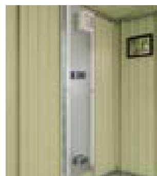
Elektropanel inkl. Steckdosen und LED-Beleuchtung, ohne optionalen Starkstromanschluss Breite x Höhe: 47 x 180 cm
