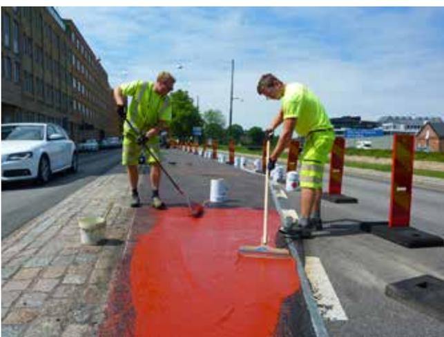
Eine Erweiterung der Produktpalette wurde mit der Entwicklung von PlastiRoute®hot climate = hc erreicht. Speziell in klimatisch anspruchsvollen Gebieten wird PlastiRoute®hot climate = hc bereits sehr erfolgreich eingesetzt und kann, je nach Maschinenteknik, in verschiedenen Materialklassen geliefert werden.
