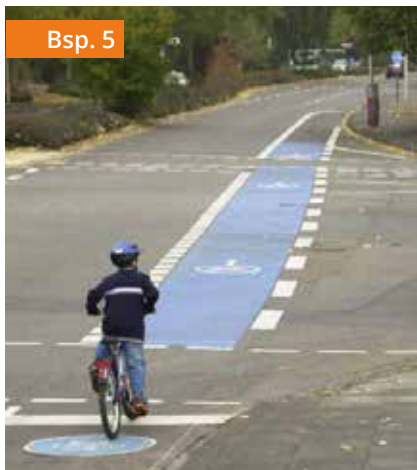
Fahrradfurten 0,5 x 0,25m Strich Lücke 0,5:0,2m Dickschichtmarkierung
