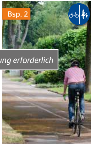
Getrennter Fuß- und Radweg, (baulich getrennt).
