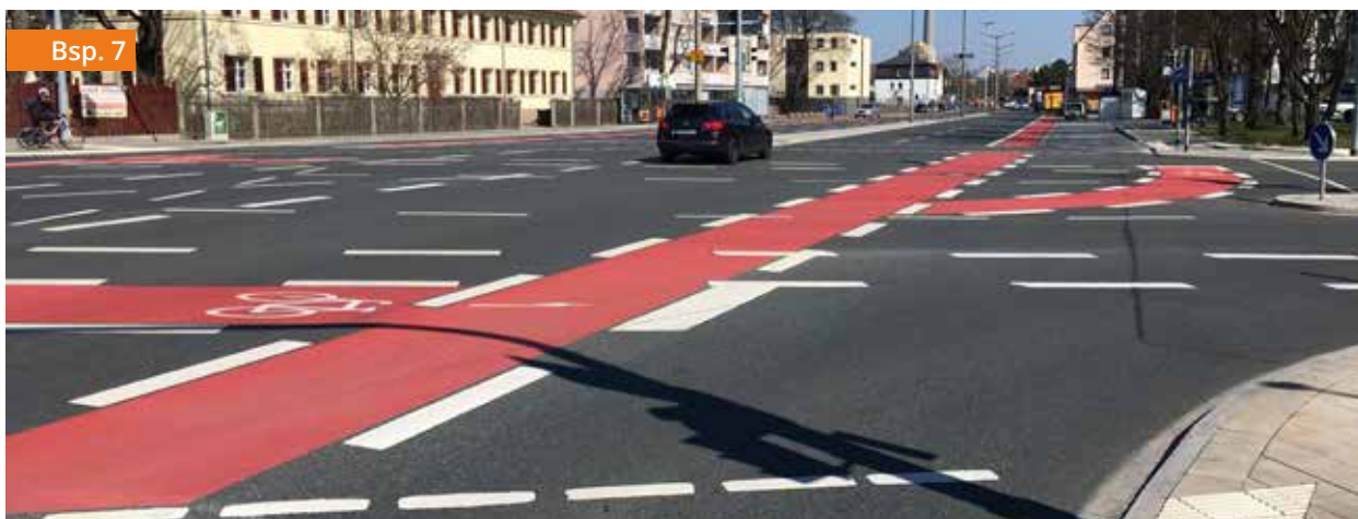
Rot eingefärbte Radverkehrsanlagen : Schichtdicke 1-2mm , bei starker Belastung 3mm, Farbton RAL 3020 oder 3013 (Nürnberg, PlastiRoute 2K-Kaltplastik + PREMARK Symbole und Pfeile)
