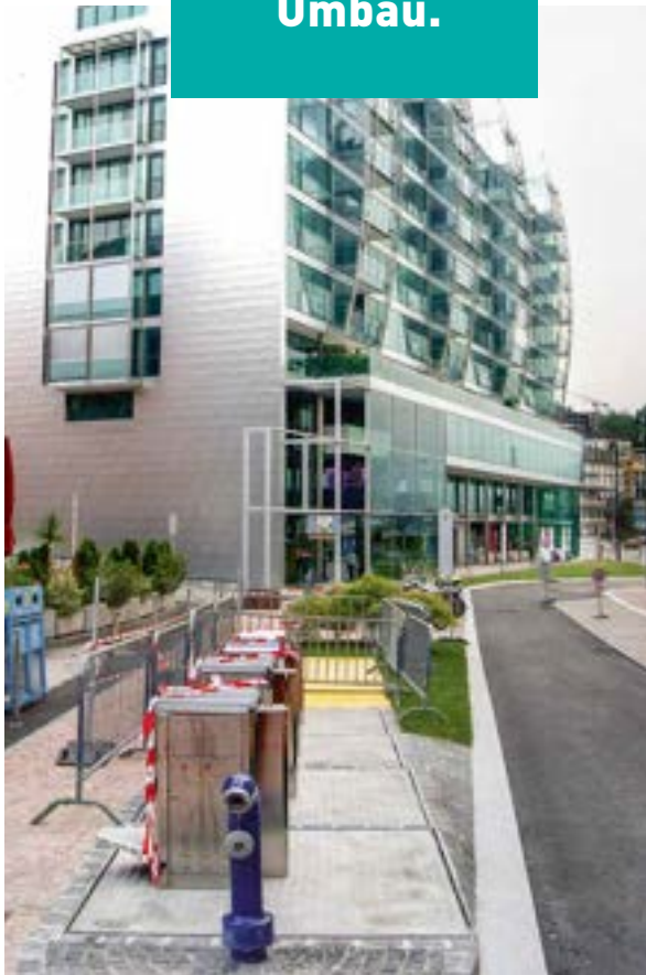
Vor dem Umbau ...
