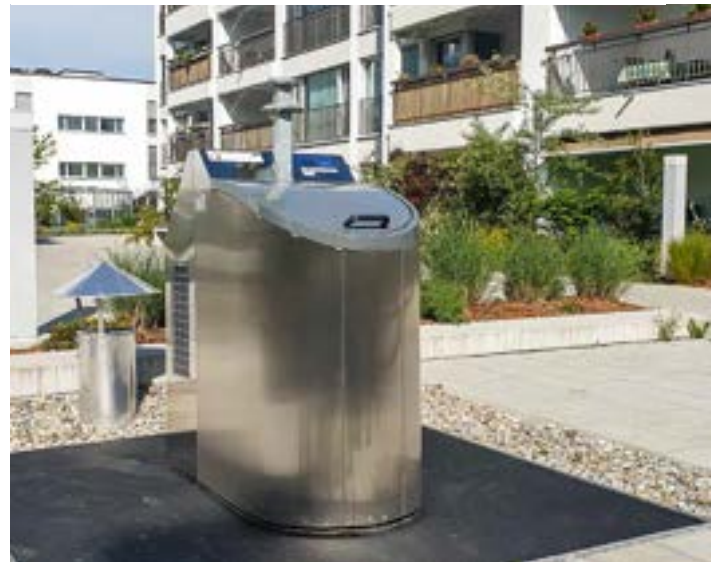
Untergrund-Anlage mit Vilaro-Einwurfsäule mit elektronischem Zutritt/Verwiegung und Solar-Speisung.
