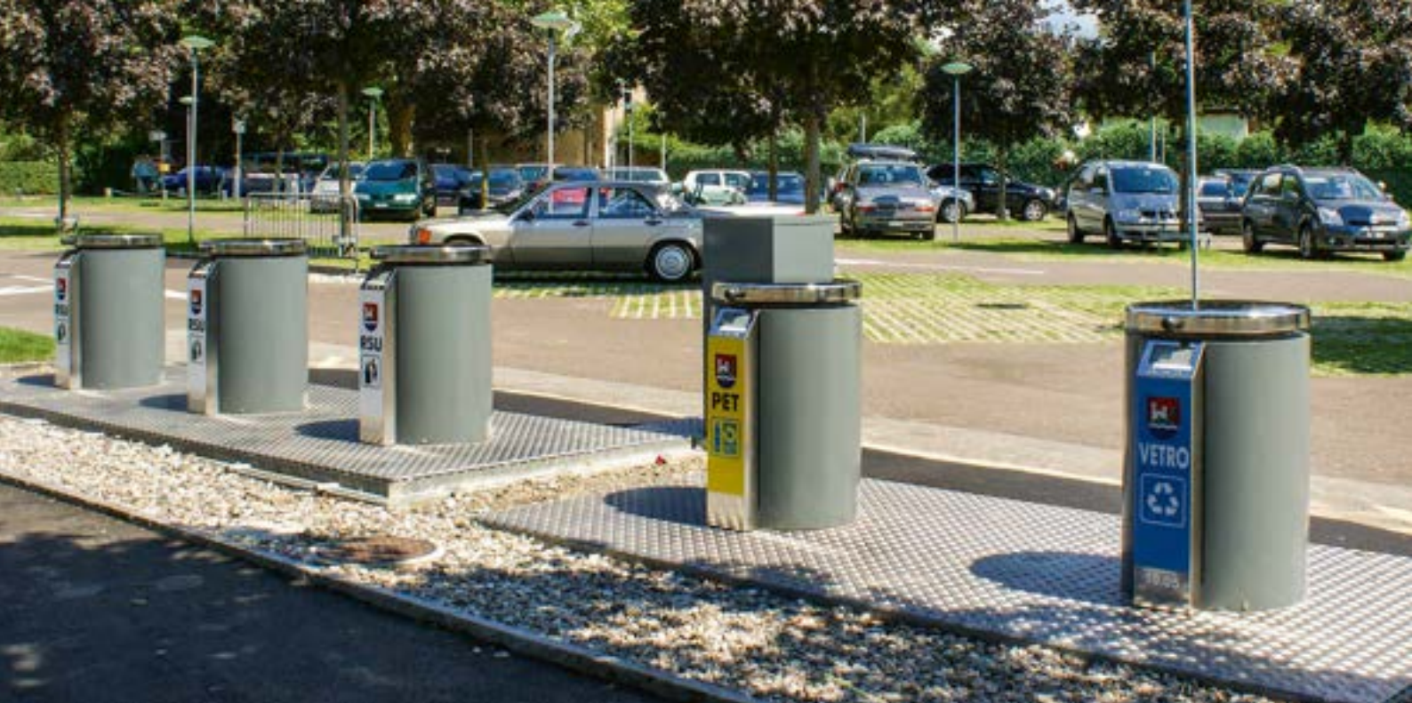
Einwurfsäule mit integriertem Zutrittssystem und Verwiegung in Caslano (CH).
