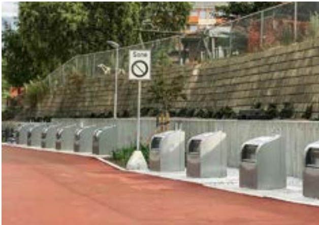
Marino-Sammelstelle mit 2-Haken-Entleerungssystem für die Sammlung von Papier und Restabfall in Oslo (NO).
