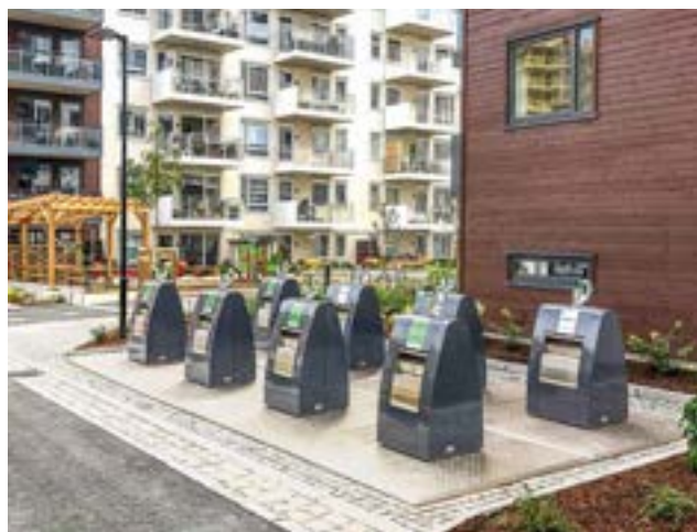
Sub-Vil Lugano mit elektronischer Zutritts- und Füllstandsüberwachung in Oslo (NO).
