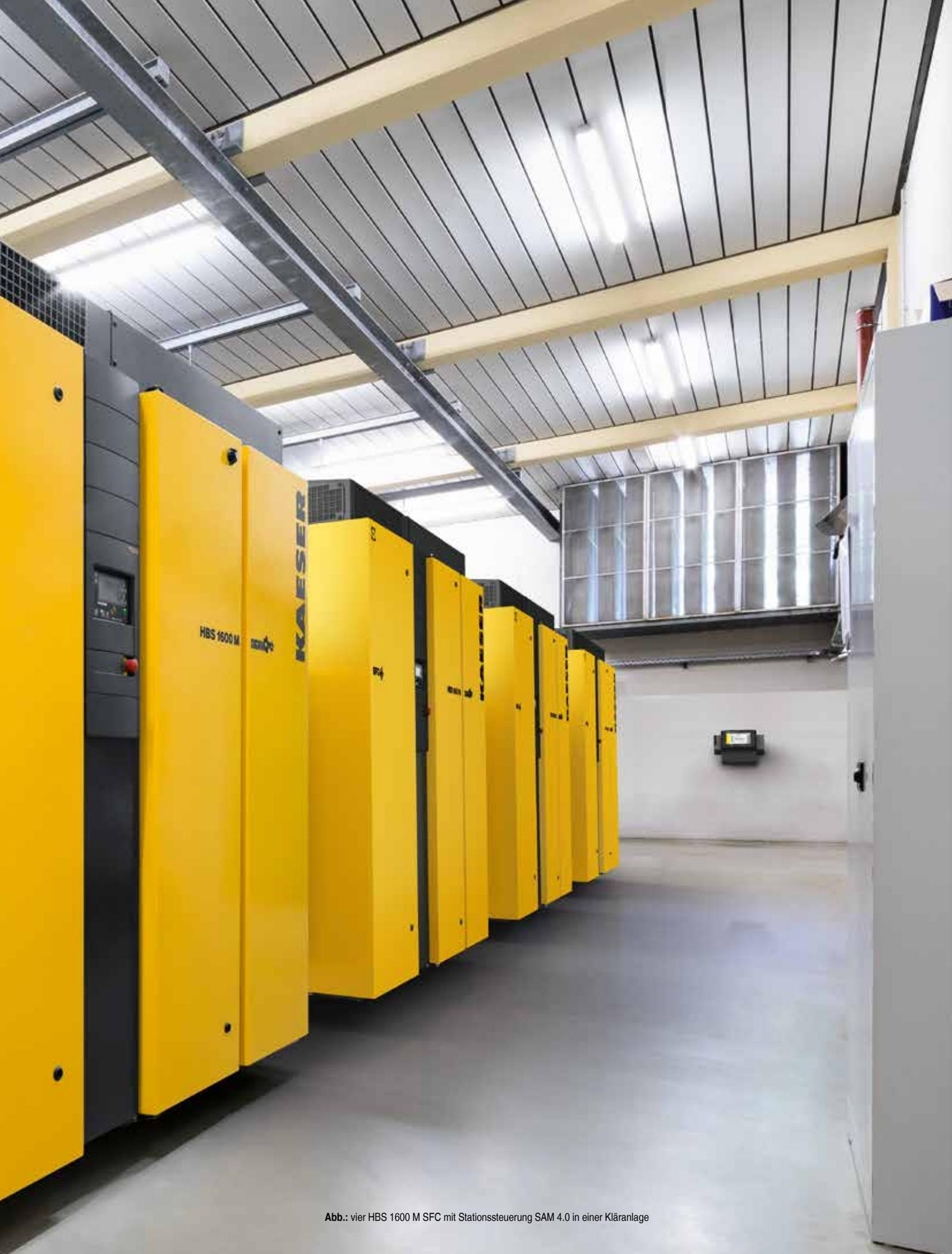
Abb.: vier HBS 1600 M SFC mit Stationssteuerung SAM 4.0 in einer Kläranlage
