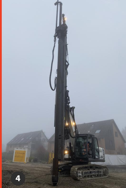
Die Drehbohrgeräte sind für unterschiedliche Bohr- & Rammverfahren einsetzbar:
