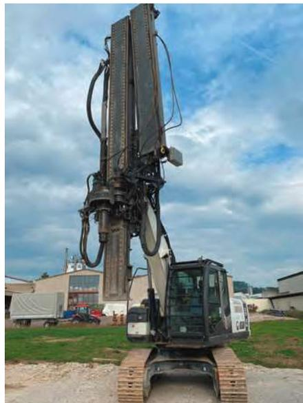
■ Bohrspfähle vom Typ SOB mit GEAX EK 90 und Mecbo Betonpumpe bohren.
