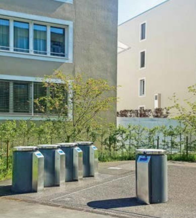
Installation Lift-o-Mat LU 500 avec quatre conteneurs sur roues de 770 l escamotés pour les déchets biodégradables.
